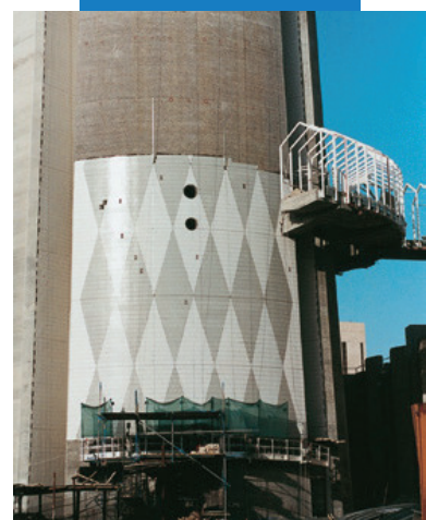
Пример укладки клинкера поверх бетона с помощью Kerabond T-R (Керабонд Т-Р) + Admix I.
